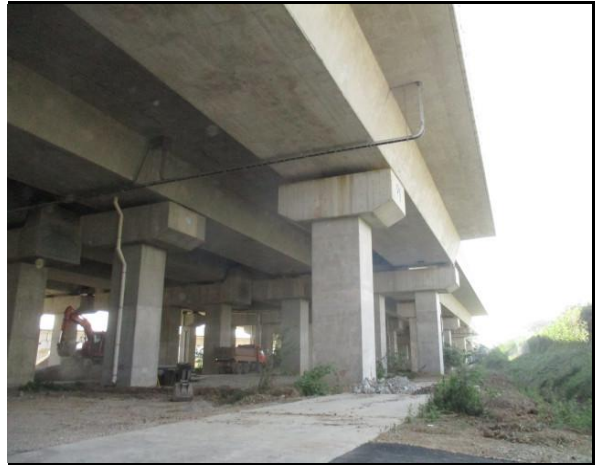
교량 측면 전경
