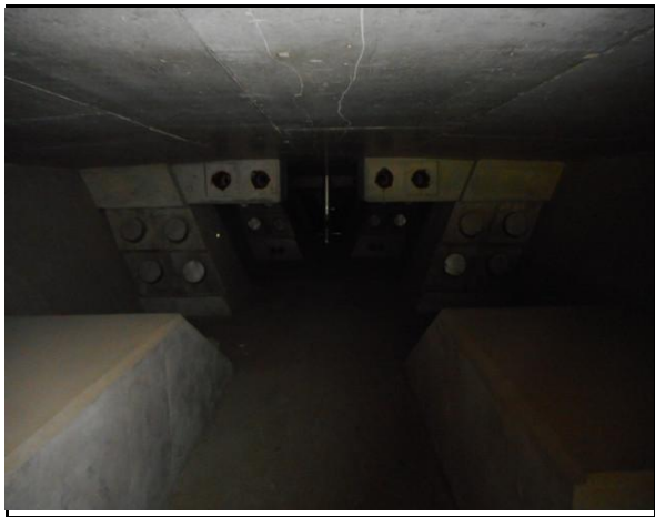
거더 내부 전경
